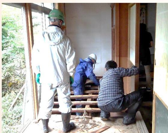
壁の150cm辺りに一本の筋が残されており、水の高さを確認できる。
